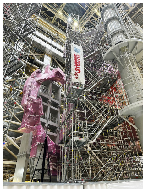
建設が進むトカマク型核融合炉
