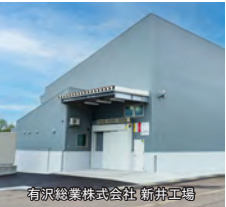
有沢総業株式会社 新井工場
