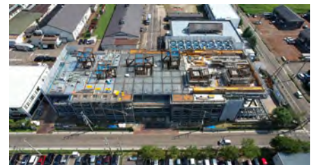
建設状況（2024年10月）
